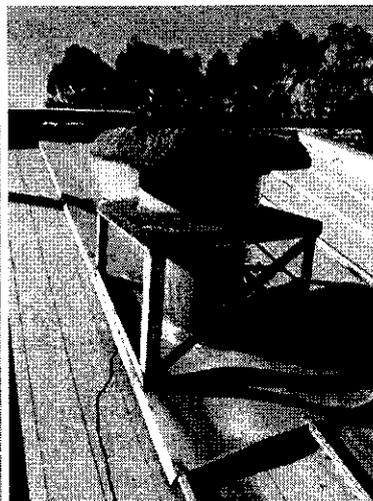
Imagen: Sellos, hojalatería a reponer y fabricación de forros.
